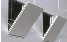
Клапаны дымоудаления и подачи воздуха
